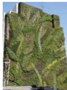
слоя ПВХ и слоя войлока. Металлическая рама крепится к стене, обеспечивая прослойку воздуха. Слой ПВХ, покрывающий металлическую раму, защищает ее от воды. Верхний фетровый слой прикрепляется к ПВХ и к нему прикрепляются семена, отростки или корни растений. Орошение и внесение удобрений происходит автоматически путем просачивания сверху вниз.
